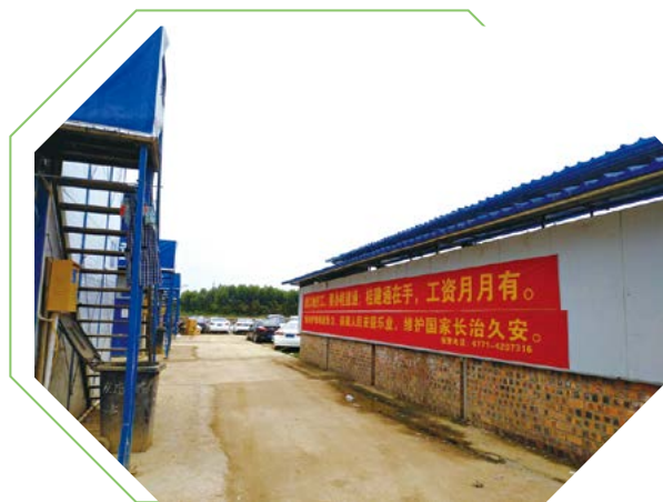
项目工地悬挂“扫黑除恶”宣传横幅
